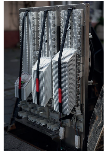
▲ Gf-UVt mit Fasermanagementsystem ausgeklappt
